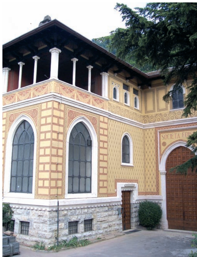
Angolo nord est a lavori ultimati
