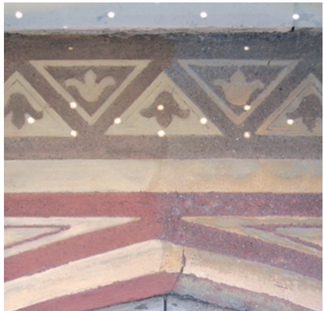
Campionatura di velatura di raccordo cromatico (sinistra).
